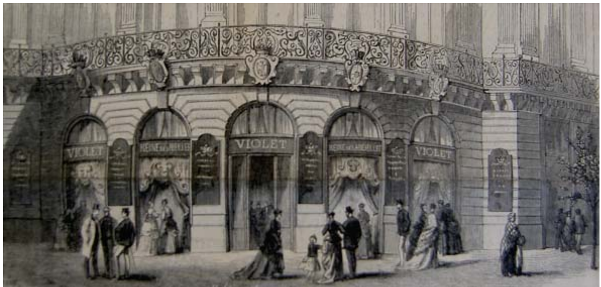
EXTERIEUR DE LA BOUTIQUE VIOLET SUR LA ROTONDE DU GRAND HOTEL ( L'Illustration , 16 octobre 1869, p. 253)
