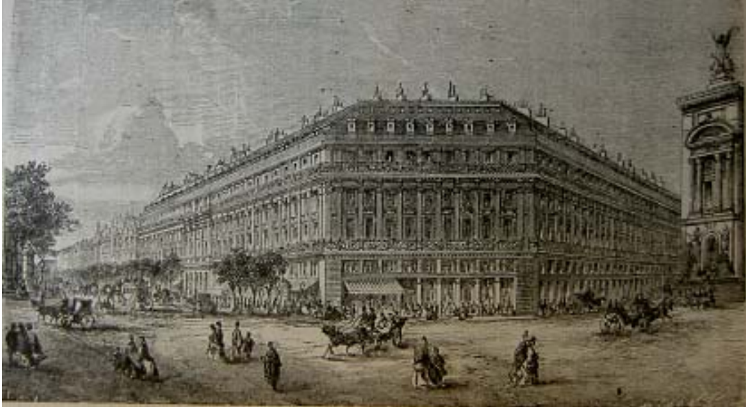
VUE EXTERIEURE DU GRAND HOTEL DE LA PLACE DE L'OPERA
